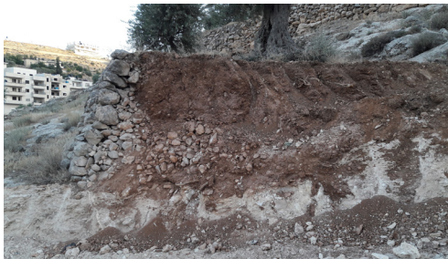
איור 10: חתך טרסה (בשל פגיעה מכאנית), בית לחם. מילוי האבן שבגוף הטרסה משמש כמסננת האוצרת נוזלים ומוצקים אך מאפשרת גם את ניקוזם (צילום: שמעון גיבסון)
